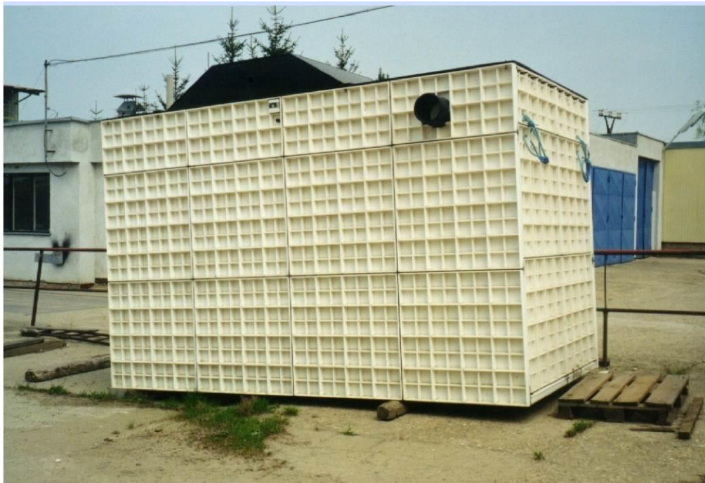
Εικόνα 2.2.1.2 Μονάδα κόμπακτ επεξεργασίας υγρών αποβλήτων με βιορότορες
